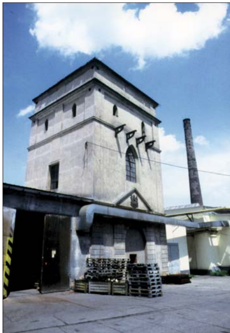
Bývalá železářna v Sedlci – dochovaná zavázeční věž vysoké pece
